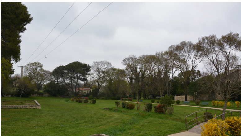
En aucun endroit du parc l'ambiance n'est forestière et c'est son ouverture qui fait son charme (en contraste avec le bâti ultra dense du village historique). Au travers d'une règle qui impose un espace boisé, le classement en Espace Boisé Classé que ce soit «à créer» ou «à conserver» est à l'opposé de ce qui fait le charme de ce parc.
