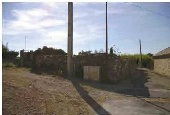
De droite à gauche : mur est du lavoir, chemin, jardin potager enclos, puits © Jennifer Gomez (2007).
