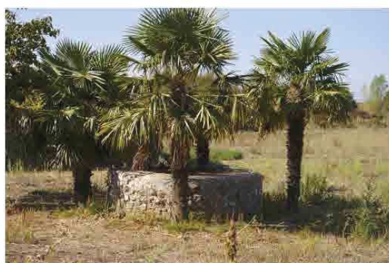
Puits de plans circulaire en moellon mixte (calcaire et grès) © Jennifer Gomez (2007).
