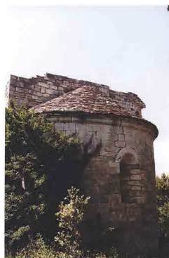
Chevet avec abside en partie restaurée et recouverte de lauze calcaire © LOINTIER Philippe (2004).
