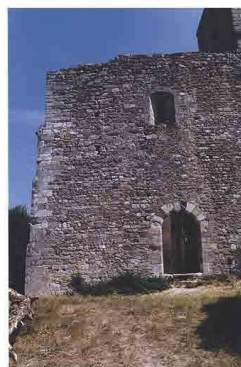
Façade occidentale en petit appareil certainement surélevée lors de la construction du clocher. © LOINTIER Philippe (2004).
