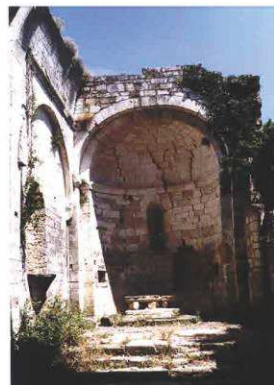
Intérieur de l'abside en cul de four © LOINTIER Philippe (2004).
