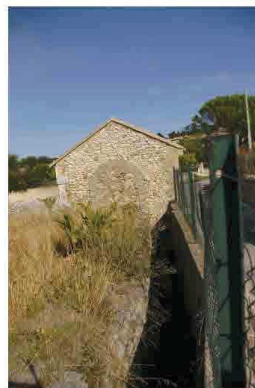
Canal d'évacuation, côté sud © Jennifer Gomez (2007).
