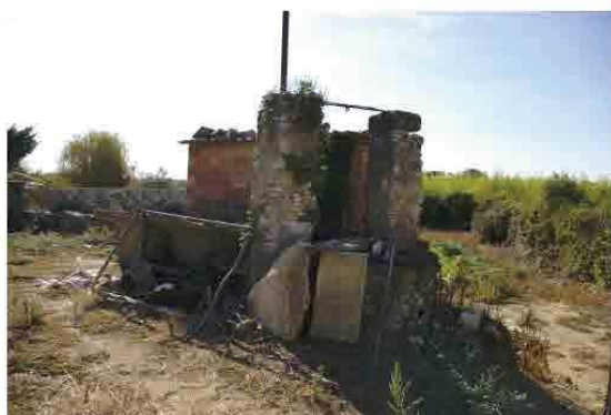
Puits situé à proximité de l'abreuvoir, avec bassin en béton et maset accolé. © Jennifer Gomez (2007).
