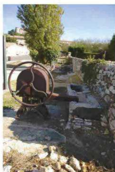
Pompe à bras et abreuvoir, côté est © Jennifer Gomez (2007).
