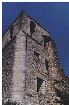
Clocher restauré dans sa majeure partie © Philippe Lointier (2004).
