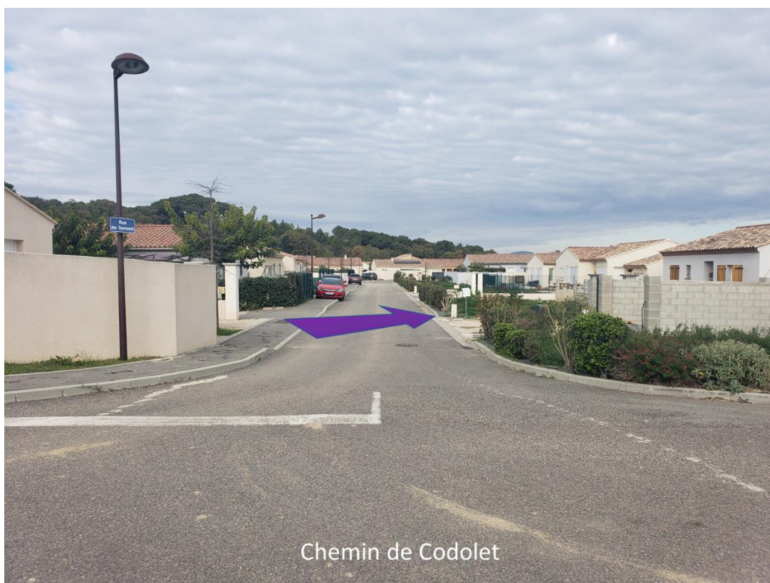
Figure 21 : Vue vers la zone de ruissellement dans le lotissement de la Grenouille
