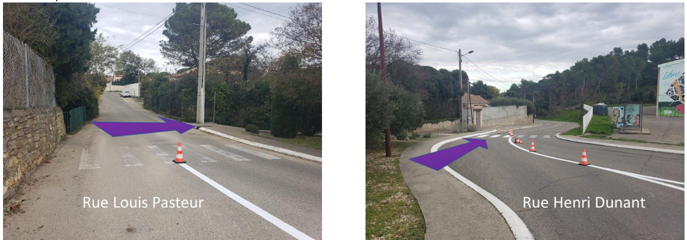
Figure 18 : À gauche vue sur le vallon passant en souterrain sous la rue Louis Pasteur / à droite vue vers l'aval de l'axe de ruissellement rue Henri Dunant
