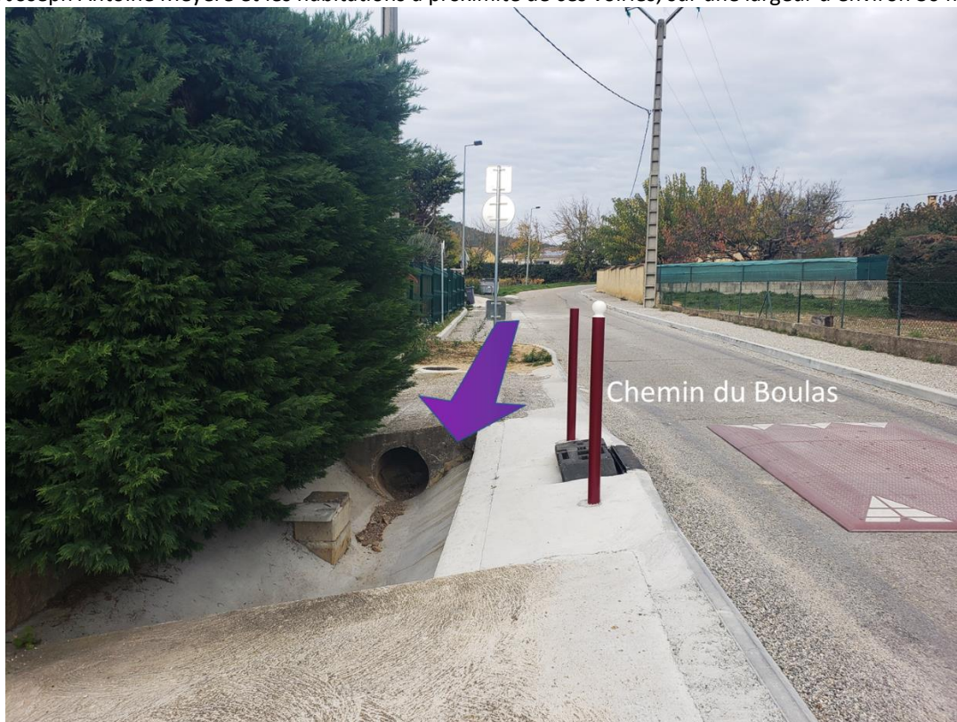
Figure 20 : Vue vers l'amont de l'axe de ruissellement, chemin du Boulas
