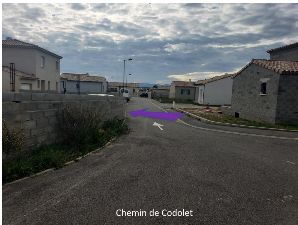
Figure 19 : Vue vers la zone de ruissellement depuis le chemin de Codolet
