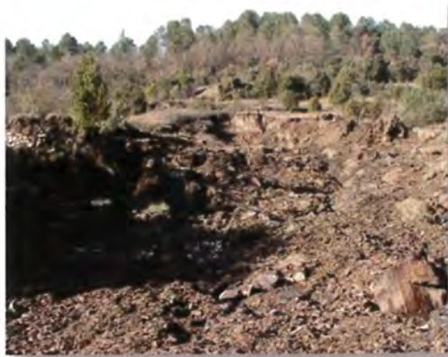
Glissement des Ribas, sept. 2002 © BRGM
