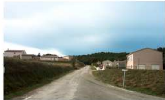
Le nouveau quartier résidentiel du Mas Blanquet s'étire le long de la route départementale n°143
