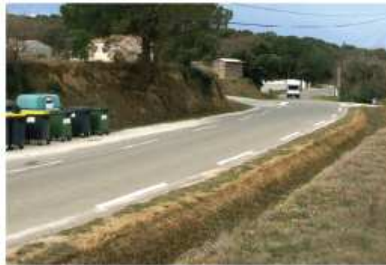
Sur la commune, de nombreux fossés, associés au maillage des voies, assurent le drainage des eaux de ruissellement (ici le long de la route départementale n° 143)
