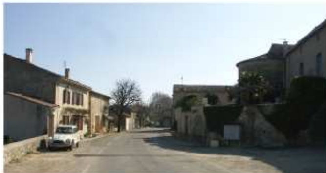
Alignement du bâti dans le village de Saint André d'Olérargues traversé par la route départementale n°23
