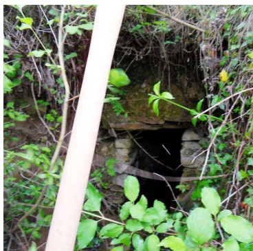
Entrée du captage
