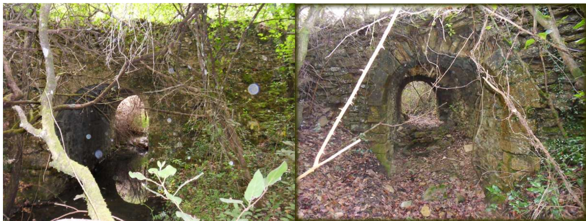
Ouvrage de passage du chemin au-dessus du ruisseau
