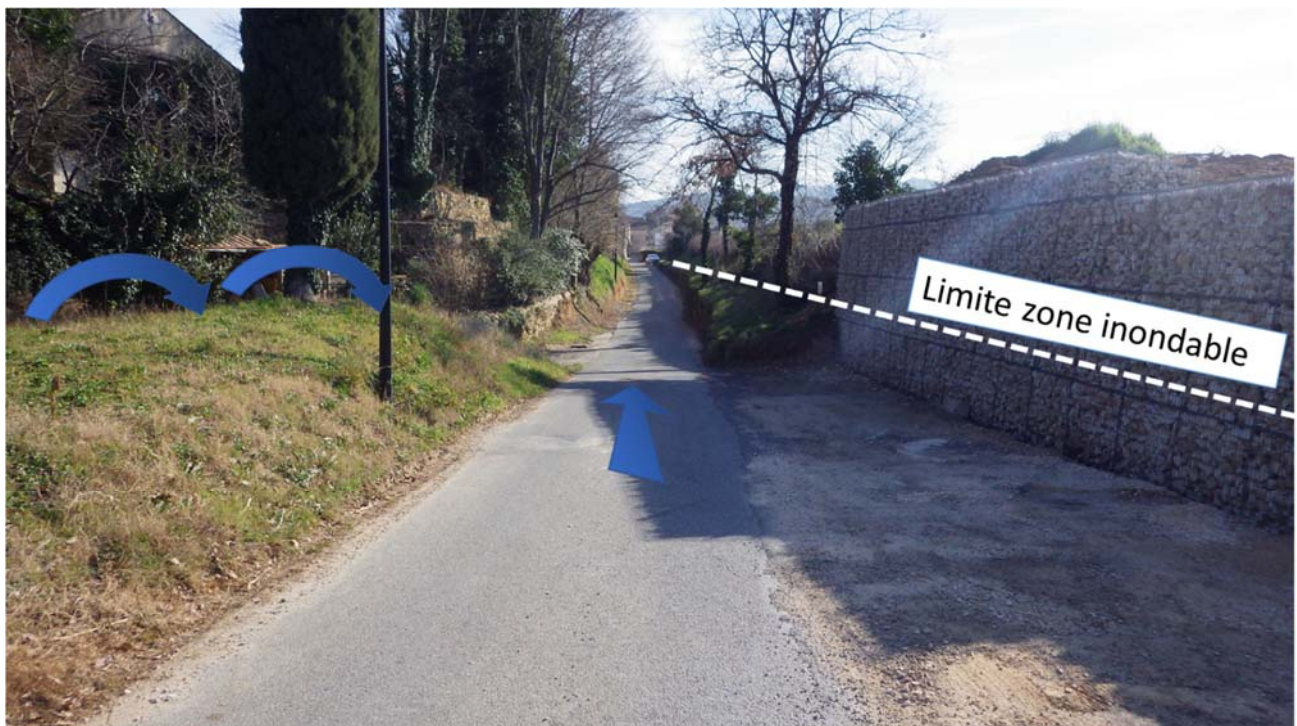
Photographie 5 : Axe de ruissellement sur voirie sur le chemin des Espais
