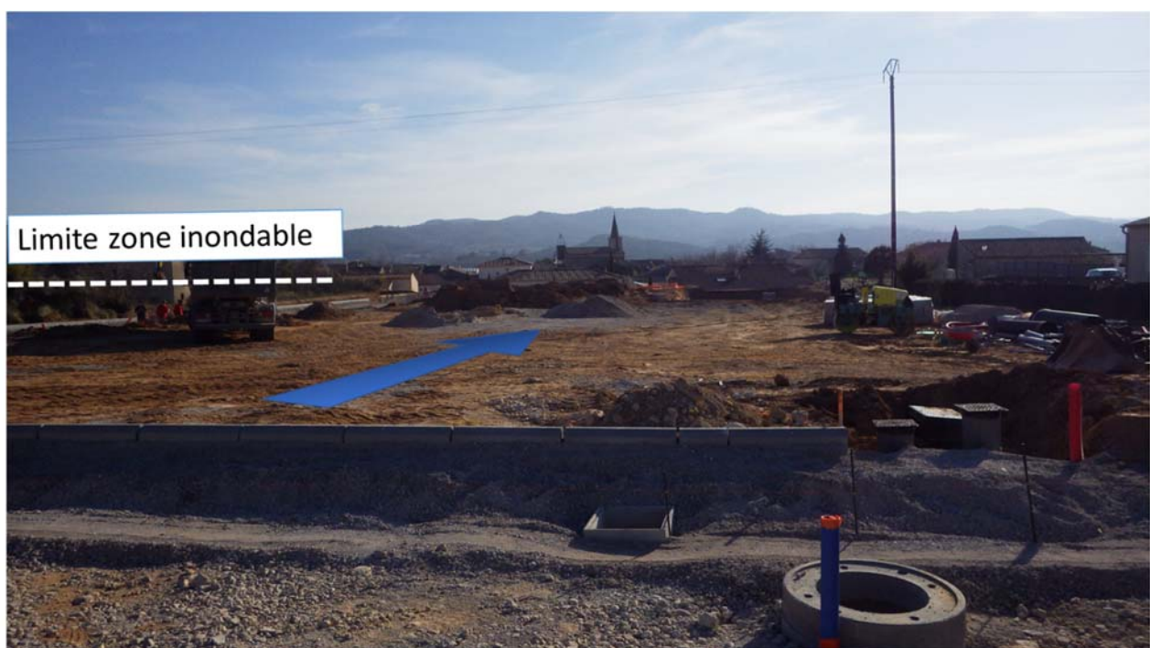
Photographie 3 : Réalisation de lots d'habitation dans l'axe du vallon des Boudettes
