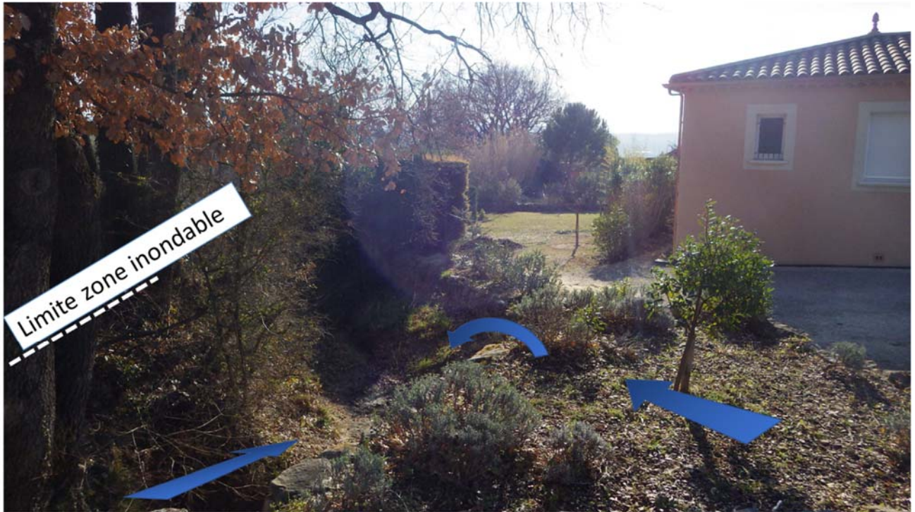
Photographie 4 : Écoulements allant dans le fossé à proximité du chemin des Célettes
