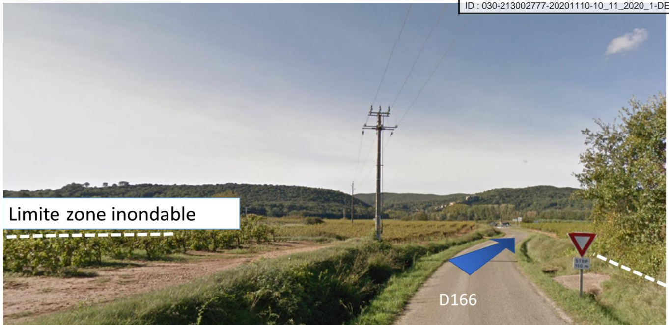
Photographie 3 : Zone inondable par ruissellement (Le Terrier)
