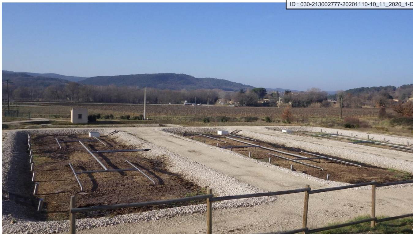
Photographie 5 : Station d'épuration en bordure de la route de Salzac – Vue vers l'aval
