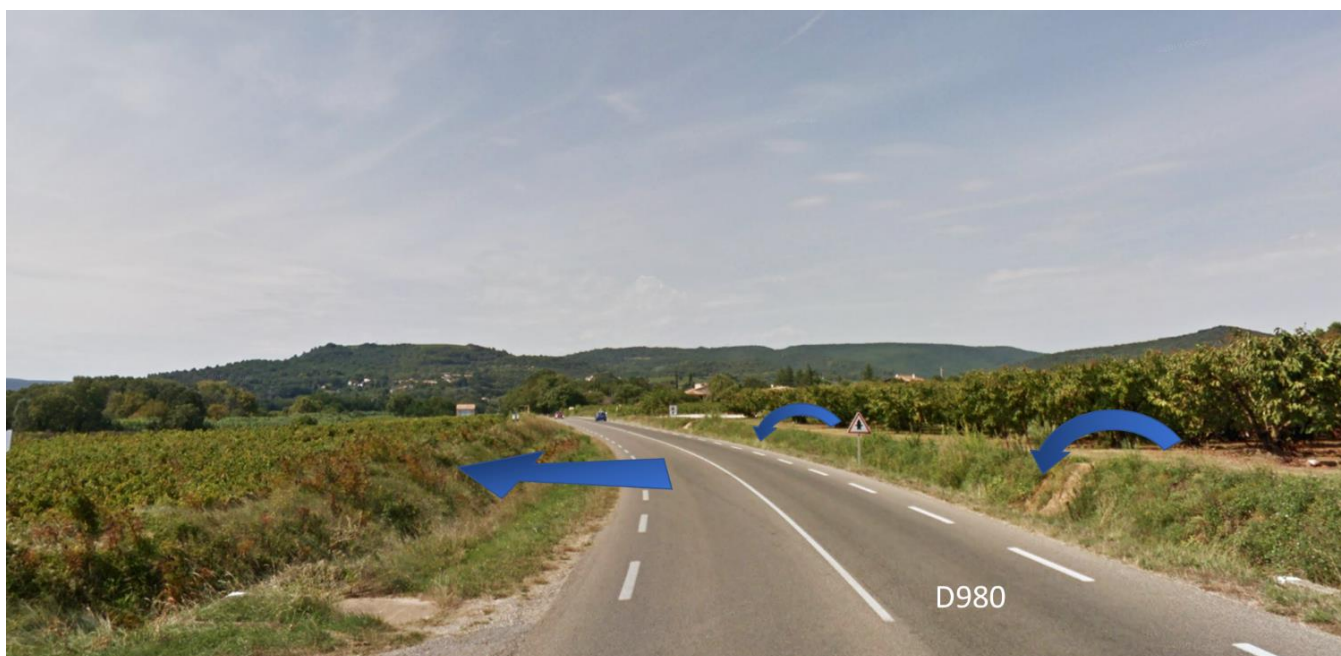
Photographie 6 : Zone de ruissellement des Quinces au niveau de la D980
