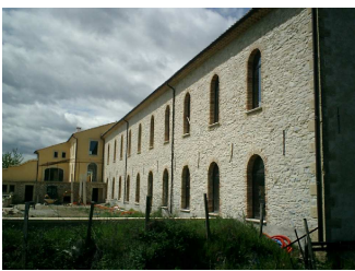
11. Moulin d'Entraigues appelé la fabrique par les 100 personnes de St Laurent y ayant travaillé pour la filature actuellement domaine viticole
