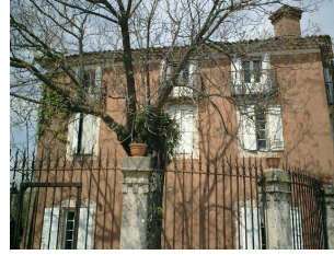
7. La Bégude relais de poste Lyon/Avignon
