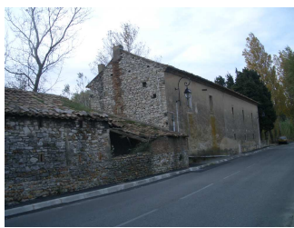
2. Mas en cours de rénovation Avenue Sembrancher
