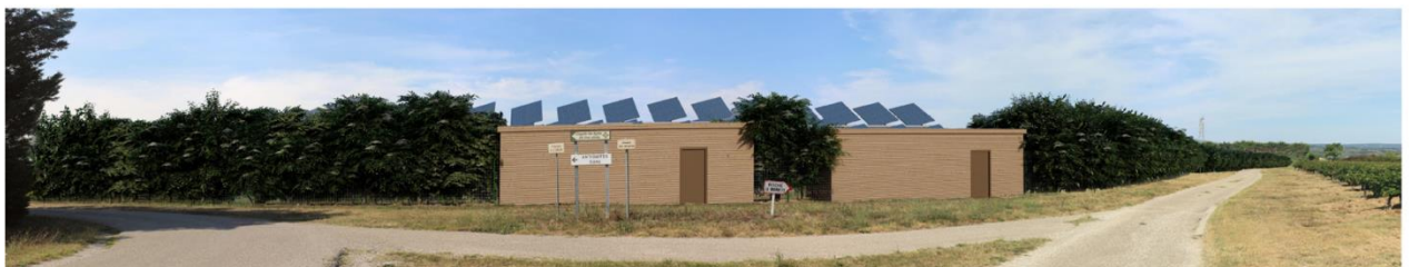
Point de vue n°1- depuis le chemin de Sihole avec haie
