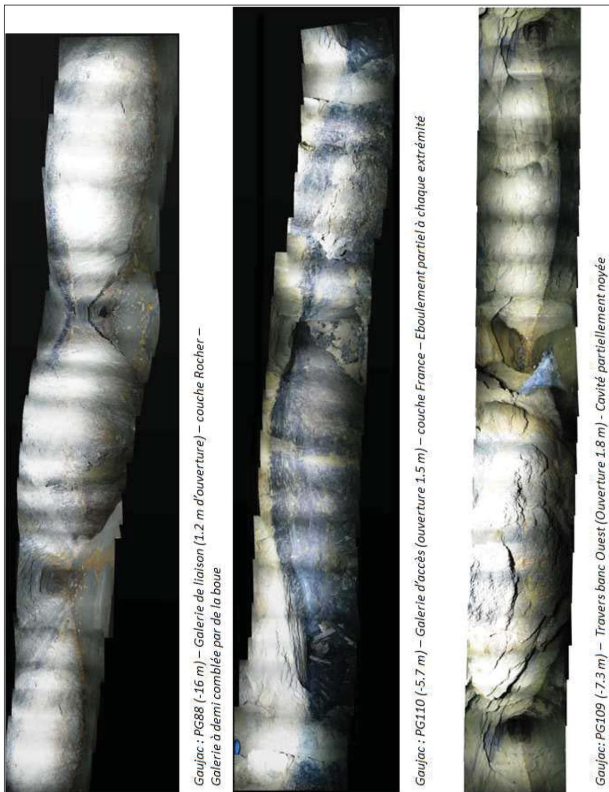
Figure 22 : Quelques travers bancs et galeries de liaison
