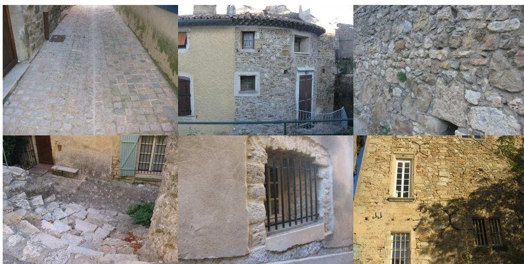
Exemples de détails architecturaux au niveau du noyau villageois : emploi de matériaux traditionnels (pierre et tuile canal), ruelles pavées et encadrement des ouvertures.
