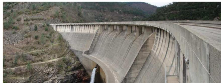
*Datant de 1977, le barrage de Sénéchas mesure 58m de hauteur maximale par rapport au terrain et peut retenir près de 16 Mm<sup>3</sup> d'eau, en amont de Goudargues.*
