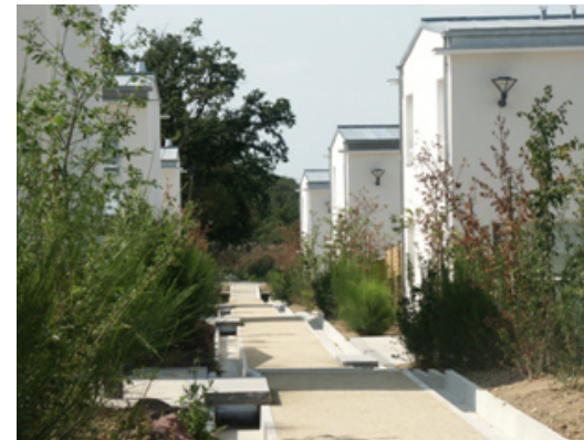
Desserte piétonne - ZAC de la Morinais - 35
